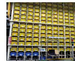
高雄岡山本洲在庫中心 Ben-Jhou Warehouse Center
