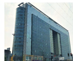
寧波營業所 Ningbo Sales Office
