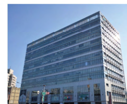
台中營業所 Taichung Sales Office
